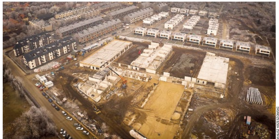
Wykonawcą inwestycji jest firma AWM Budownictwo S.A. Koszt budowy wyniesie 48 mln złotych
